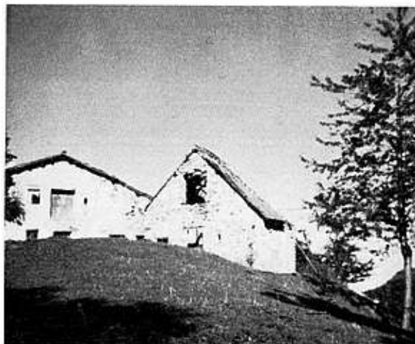
Fig. 3 Fienili Stue in Comune di Recoaro Terme. Falde di tetti a diverse inclinazioni. Si affiancano le une alle altre indifferentemente riguardo al senso della pendenza e contengono sia abitazioni che fienili o stalle.
