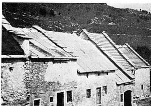
Fig. 4 Contrà Pagani di Campofontana. I tetti erano originariamente di paglia, che fu successivamente sostituita da lamiera o da tegole marsigliesi. Solo la falda della prima casa a sinistra conserva la copertura in paglia, che poteva essere usata solamente con falde a forte inclinazione.
